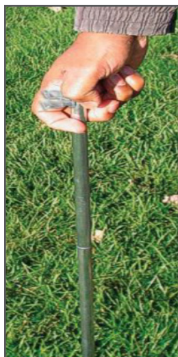
Figura 2. Instalación en suelo blando
