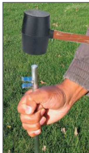
Figura 3. Instalación en suelo duro
